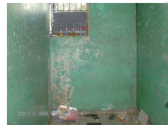
Vista Interna Celdas
