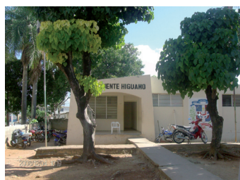
Vista Frontal, Destacamento El Higüamo
