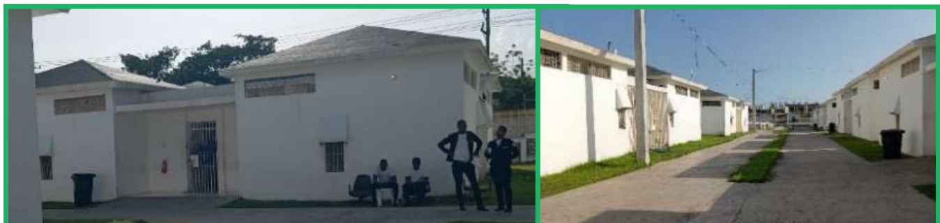
Vista exterior de los alojamientos
