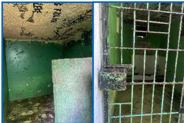
Celdas de aislamiento del Centro de Privación de Libertad Juana Núñez de Salcedo.
