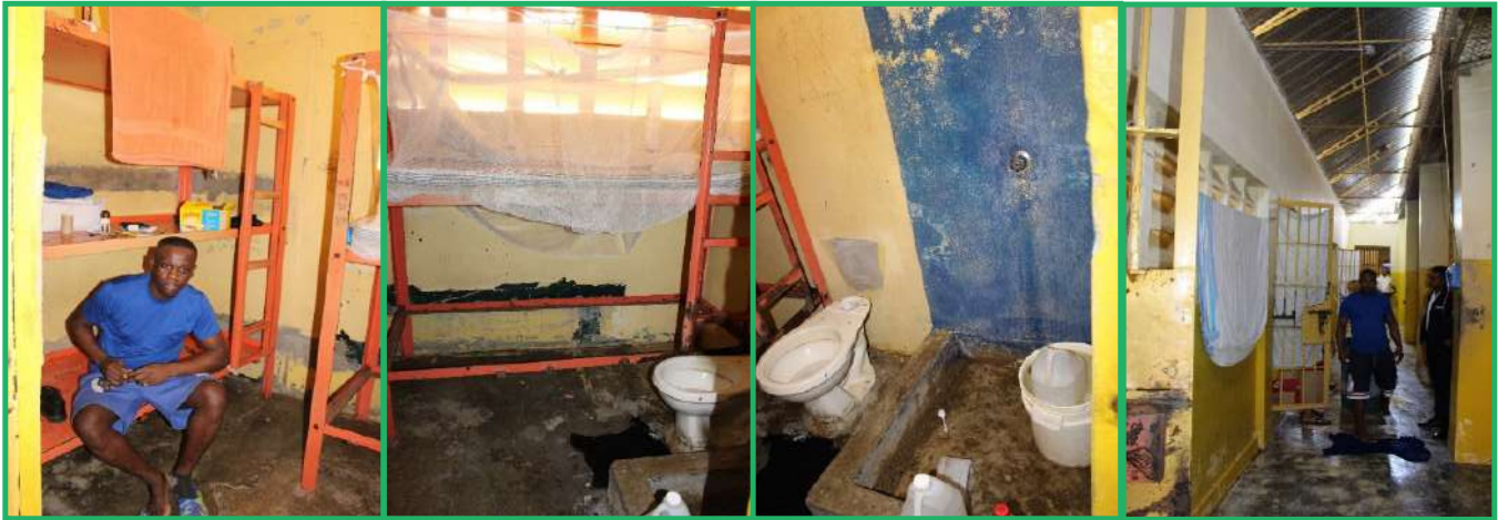
Área de aislamiento, se observa los inodoros contiguos a las camas
