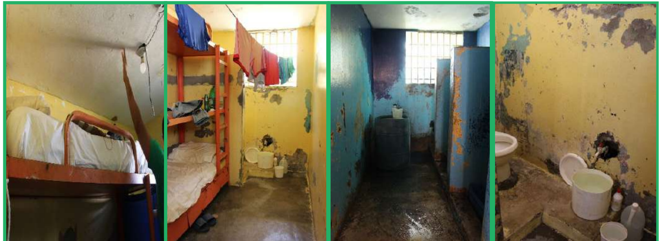
Nótese la proximidad de los camarotes al techo
