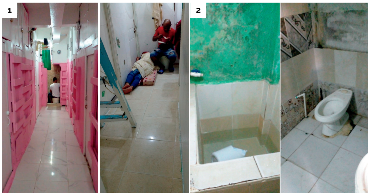
1. Vista de la entrada, área de las goletas. 2. Vista de uno de los baños.
