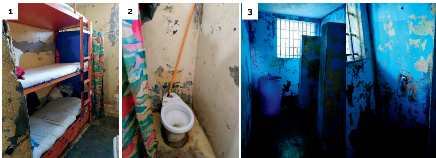
1. Vista de las celdas. 2. Vista de los baños (inodoro). 3. Área de las duchas.
