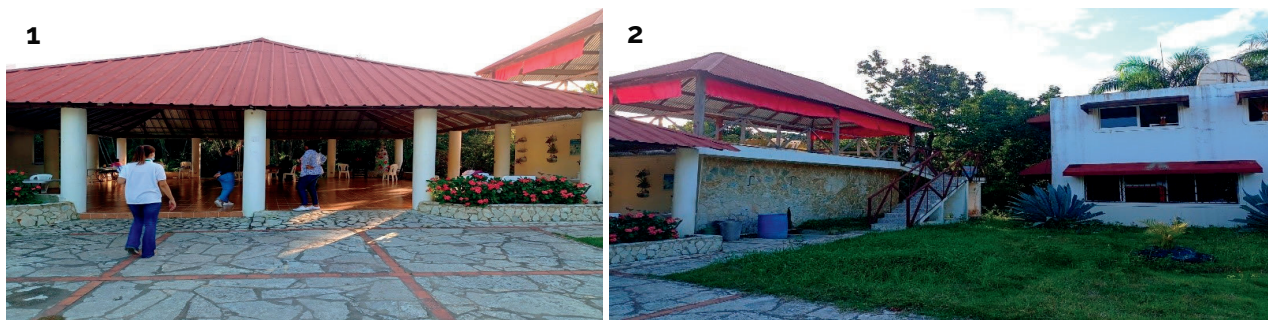
1. Vista del salón multiuso, que también funciona como un comedor. 2. Espacio de esparcimiento, contigua al salón y a las habitaciones.
