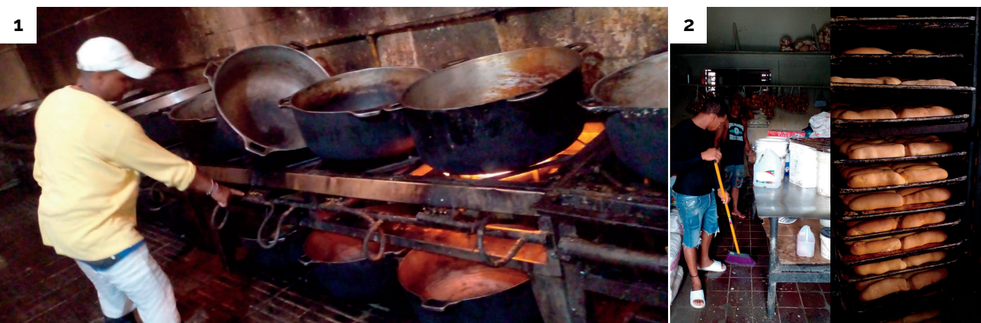
1. Vista de estufas, con la mayoría de las hornillas sulfatadas y calderos dañados. 2. Vista del área de panadería.
