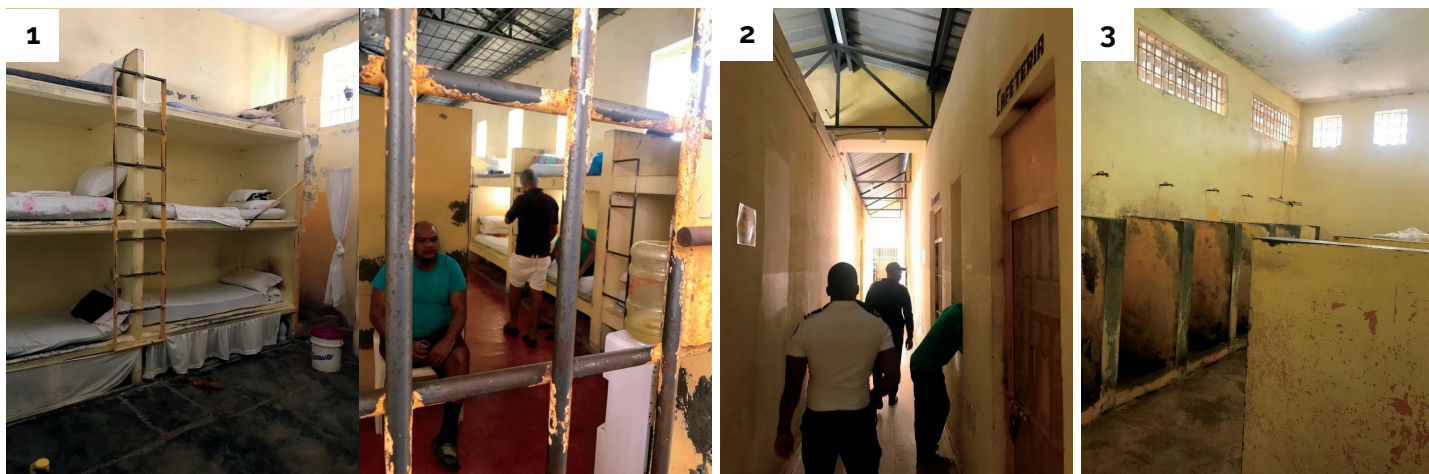
1. Vista de las celdas. 2. Vista de pasillos dentro del recinto. 3. Baño común, su pintura luce en mal estado.
